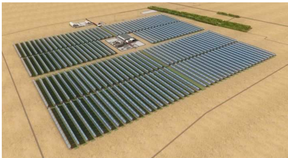
Figure 3 - La centrale solaire de Shams-1 (Abu Dhabi 2013)
