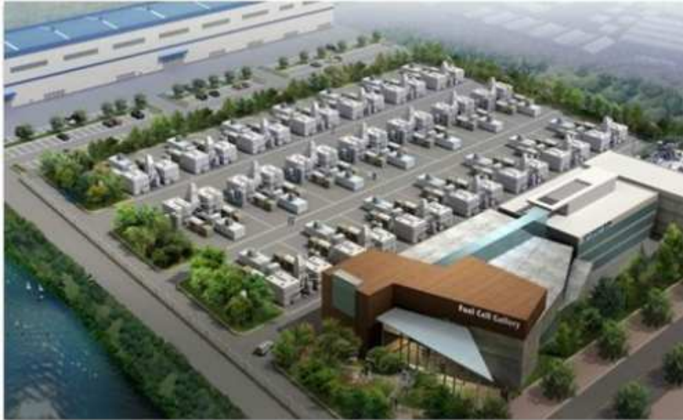
Figure 6 - La centrale de Gyeonggi (59 MWe)
